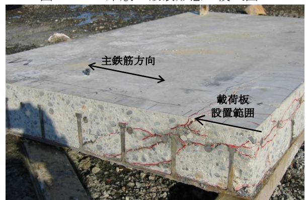
写真-2 合成床版の破壊時の切断面
