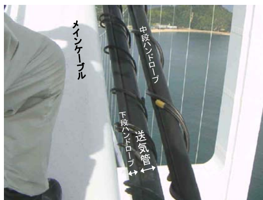
写真-1 下段ハンドロープと送気管
