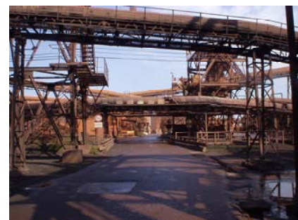
写真-1 既設橋とその周辺
