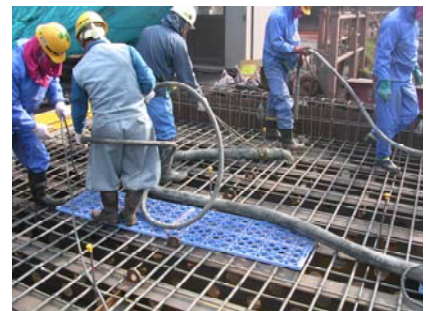
写真-3 コンクリート打設
