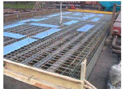
写真-2 鋼殻パネルの設置状況
