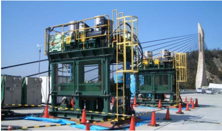
写真1 起振機設置状況
