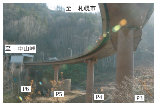
写真-1 無意根大橋の全景 (P3～P6 径間)
