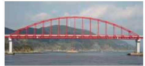
図-1 樺島大橋全景
