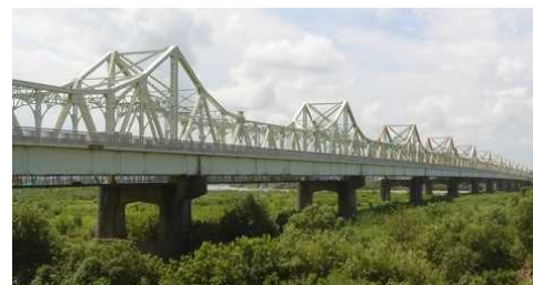
図1 計測橋梁(長生橋，長岡市)
