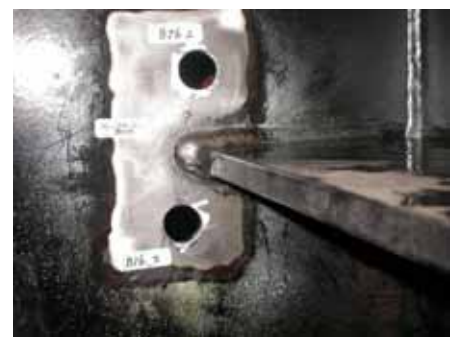
写真3 ストップホール施工
