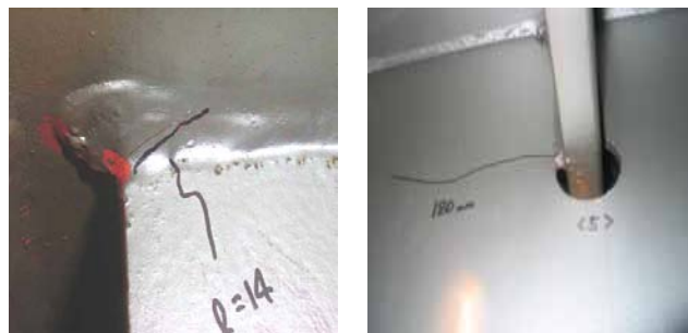
写真-1 代表的なき裂写真
