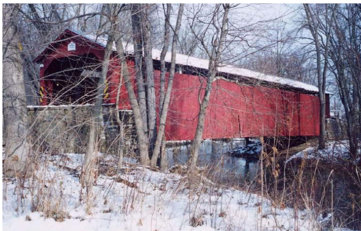
写真-1 現存する最も古いカバードブリッジ(Rishel 橋)
