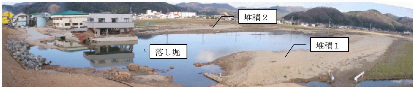
図1 円山川破堤地周辺の概況（2005年12月撮影）
