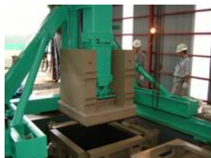
写真-4 AWFCS 全景
