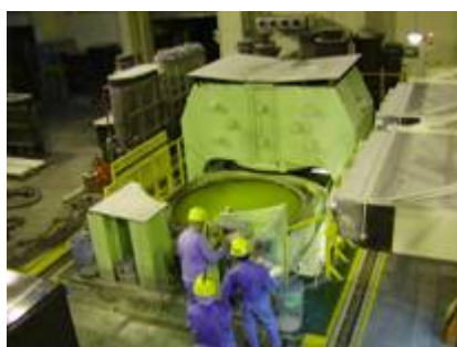
写真-1 CIP装置全景
