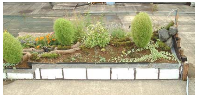
写真2 発泡スチロールによる嵩上げの様子
