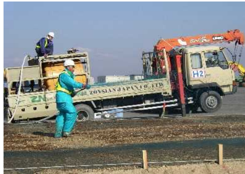
写真-2 種子吹付工法(ハイドロシーディング)
