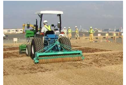
写真-3 種子散布工法(ドロップシーディング)
