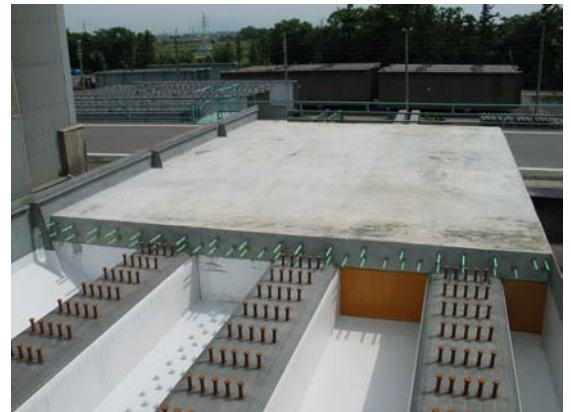
写真-1 施工試験
