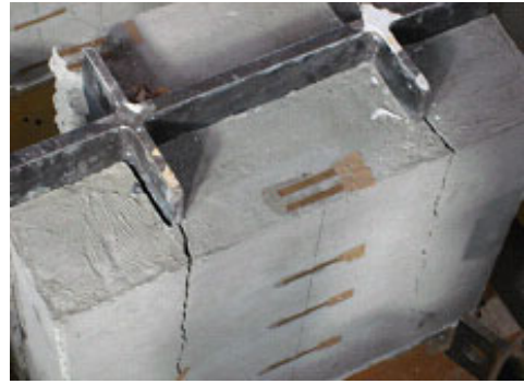
Photo.2 ひび割れの様子 (S.D-B50-L300-H100)
