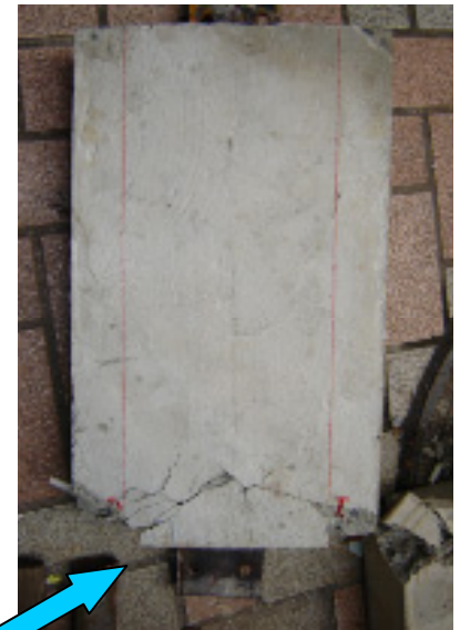
図 3 静的試験による破壊状況 (コンクリートの斜め引張破壊)
