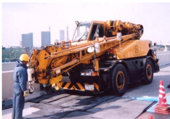
写真-1 端横桁振動計測状況
