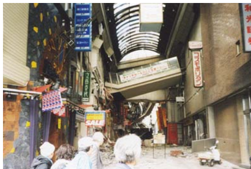
写真-1 阪神大震災における被災状況
