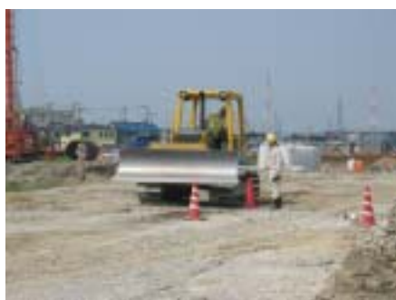
写真-1 ブルドーザーによる加振状況
