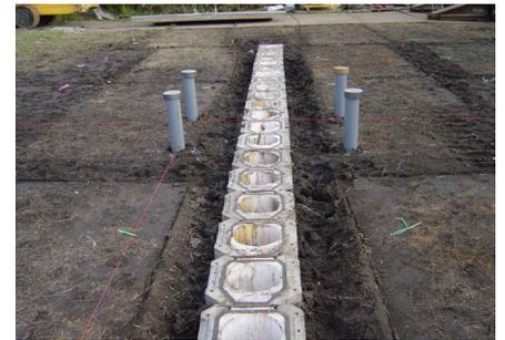
写真 - 1 合成遮断壁の埋設状況
