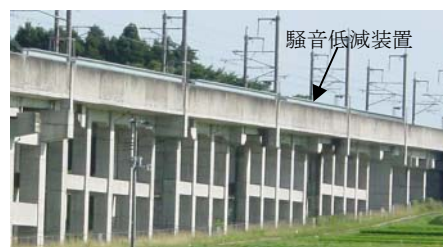
図3 騒音低減装置仮設箇所の全景
