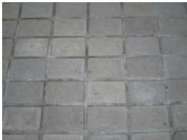
写真1 敷設インターロッキング
