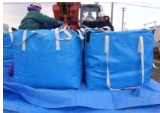
写真-1 焼却灰充填状況
