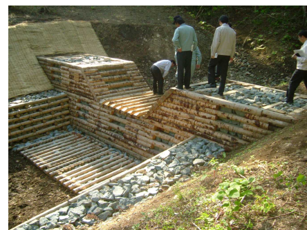
写真4 治山ダム(岩手県)
