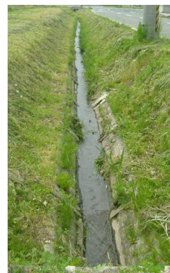
写真2 木製水路 （岩手県）
