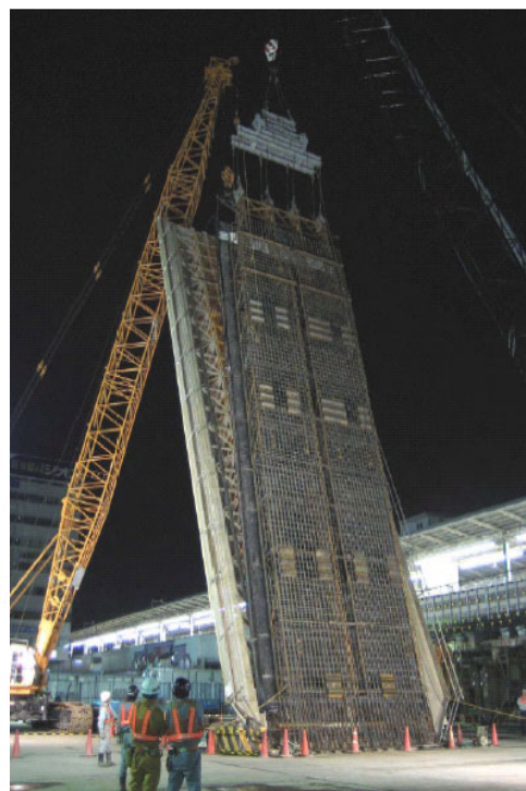
写真-1 建て込み状況
