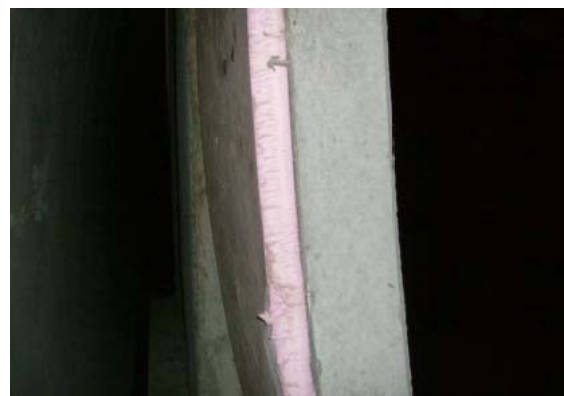
写真.1 内装板と断熱材 (PEフォーム)
