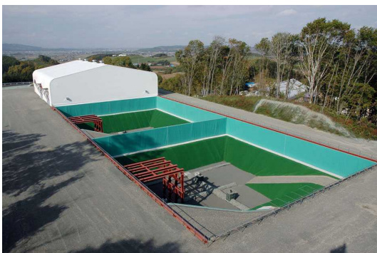
写真-1 処分場全景
