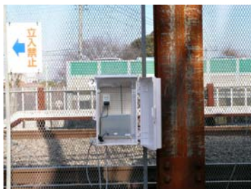
写真-3 現場でのノードの状況
