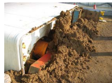
写真-2 アプローチ掘進状況
