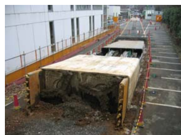
写真-3 シールド到達状況
