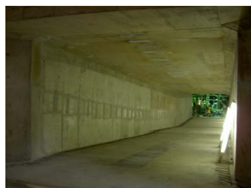
写真-2 躯体構築完了全景
