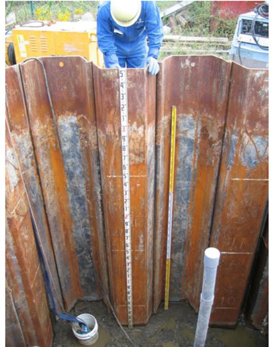
写真3 No.6~10の止水状況
