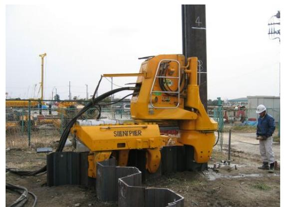
写真2 油圧式圧入機による打設状況
