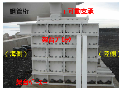
写真 1 1A 橋台支承架台（南工区）
