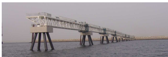
写真 3 南工区施工状況（2006年4月） （若築・日立造船・吉田共同企業体）
