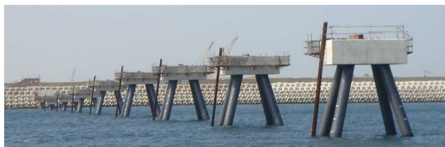
写真 2 北工区施工状況（2006年4月） （東亜・新日鐵・国土総合共同企業体）
