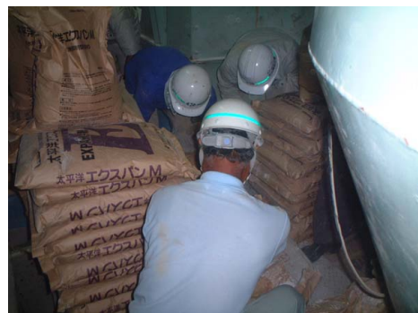
図-6 膨張材の添加状況
