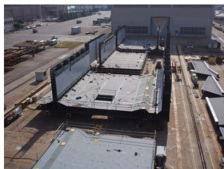
(1) 中組立ヤード
