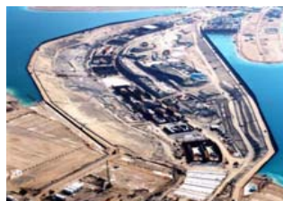
写真-3 躯体構築工
