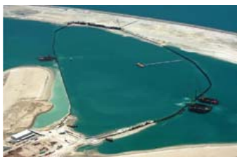
写真-2 締切工（鋼矢板打設）
