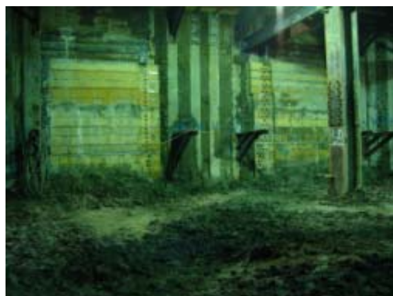
写真-3 FFU 横矢板設置全景
