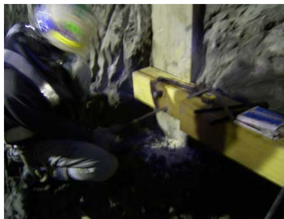
写真-1 FFU 横矢板施工状況
