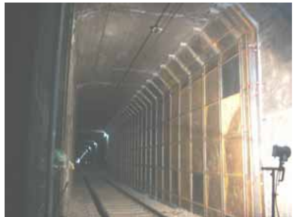
写真 浅草線内鋼製防護壁
