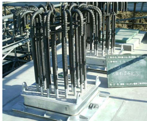
写真-4 設置・モルタル充填終了
