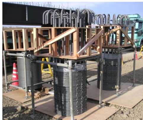
写真-3 鉄筋組立
