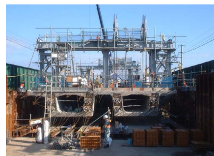
写真4 桁降下完了
