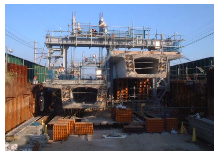
写真3 桁降下状況
