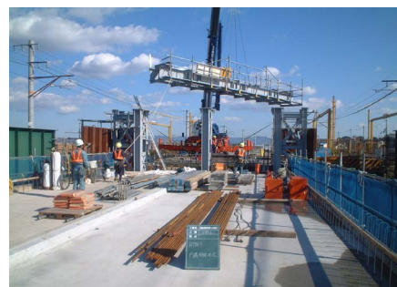
写真1 門型構台の設置
