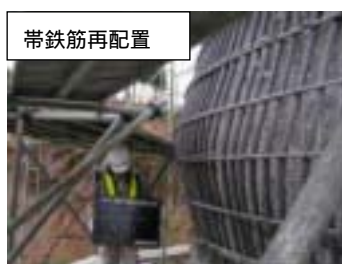
図2 橋脚の補強方法
