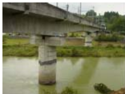
写真1 段落とし部の被災状況
