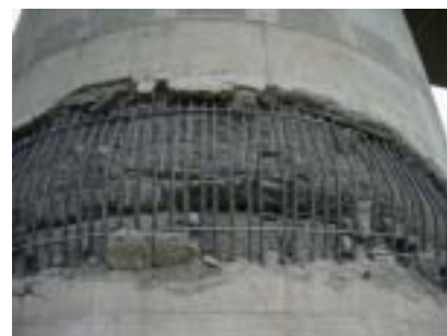
写真1 段落とし部の被災状況
