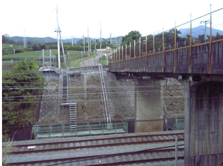
写真-2 仮設設備設置状況
