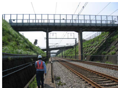
写真-1 3径間単版式ラーメンRC跨線橋
