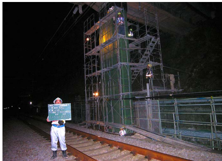
写真-3 枠組足場設置状況
