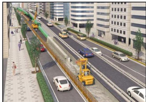
図-4 プレキャスト擁壁(拡幅部)の施工
