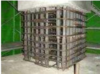
写真2 機械式継手固定部分
