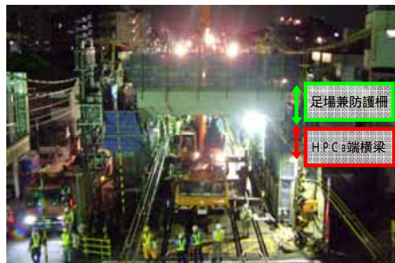
写真 3 軌道内からの梁部材の架設
