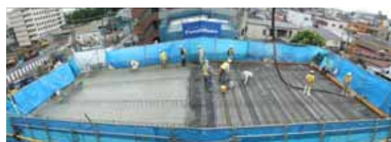
写真 4 コンクリート打設状況
