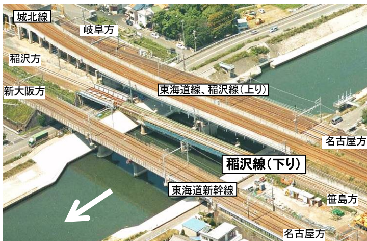
写真-1 現場付近航空写真
