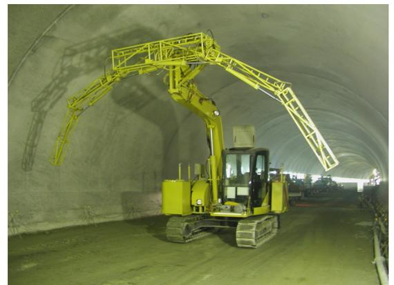
写真-1 バックホウ装着型噴霧養生装置
