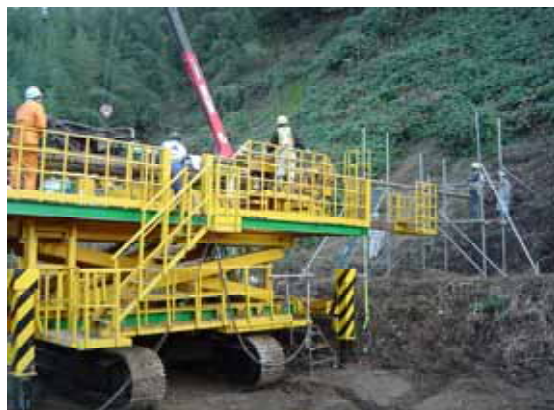
写真 2 砂質地盤削孔実験状況
