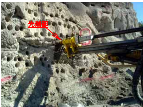
図-3 凹凸のあるコンクリート壁に押しつけたガイド管先端部の状況
