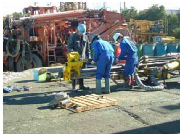
図-4 EG-Slitter の油圧削岩機への設置状況
