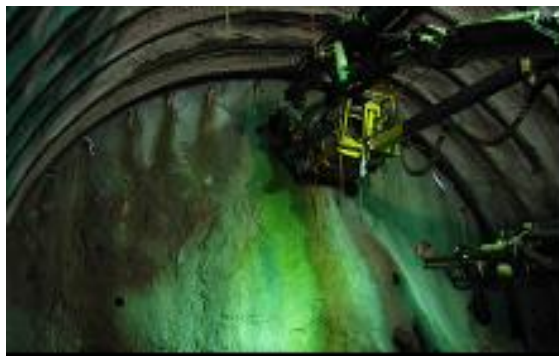
写真-1 切羽における前方探査実施状況
